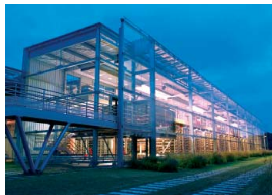
Usine de traitement par nanofiltration à Méry-sur-Oise
